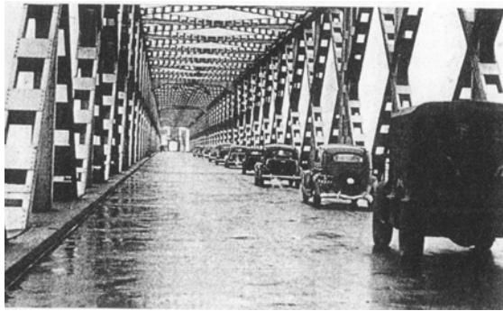
fig.4 Moerdijkbrug (tegenwoordig Spijkenssnerbrug) stabiliteitsverbanden in langs- en dwarsrichting.
