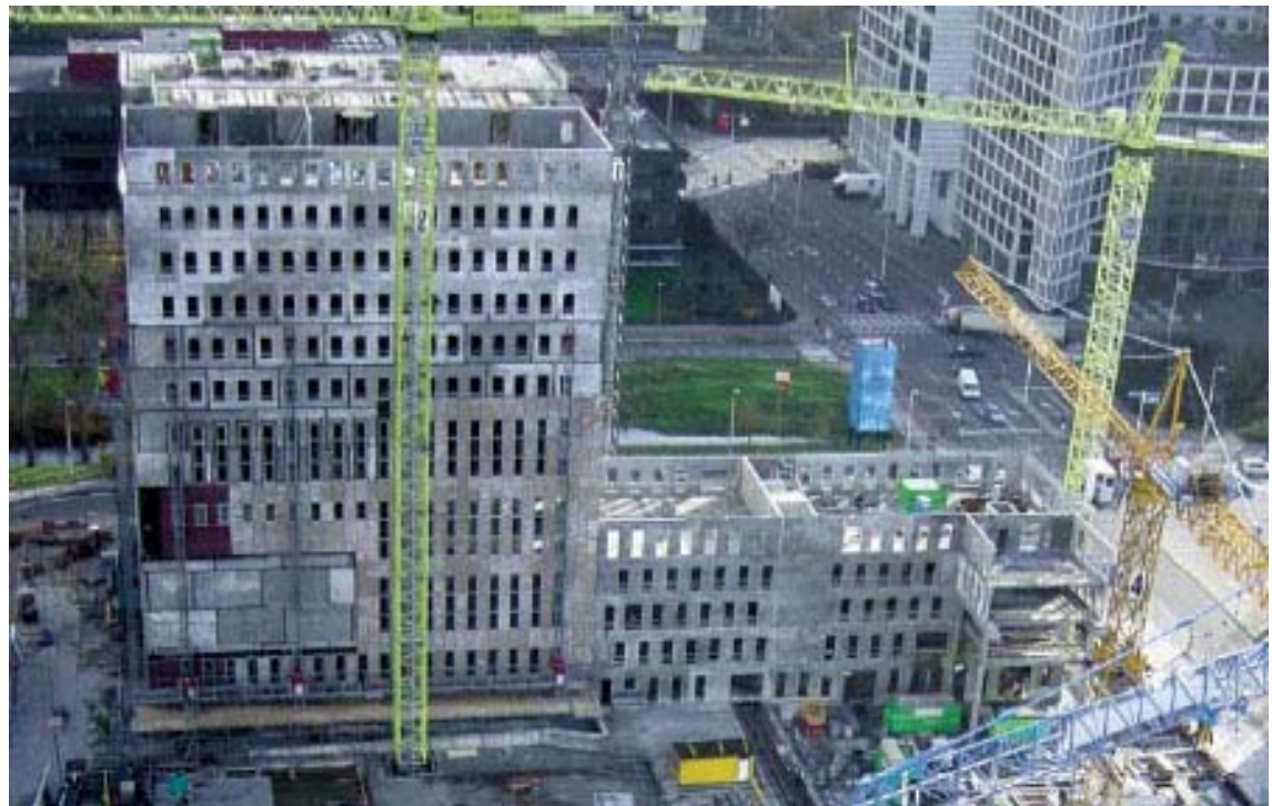
Ruwbouw dragende gevelelementen
